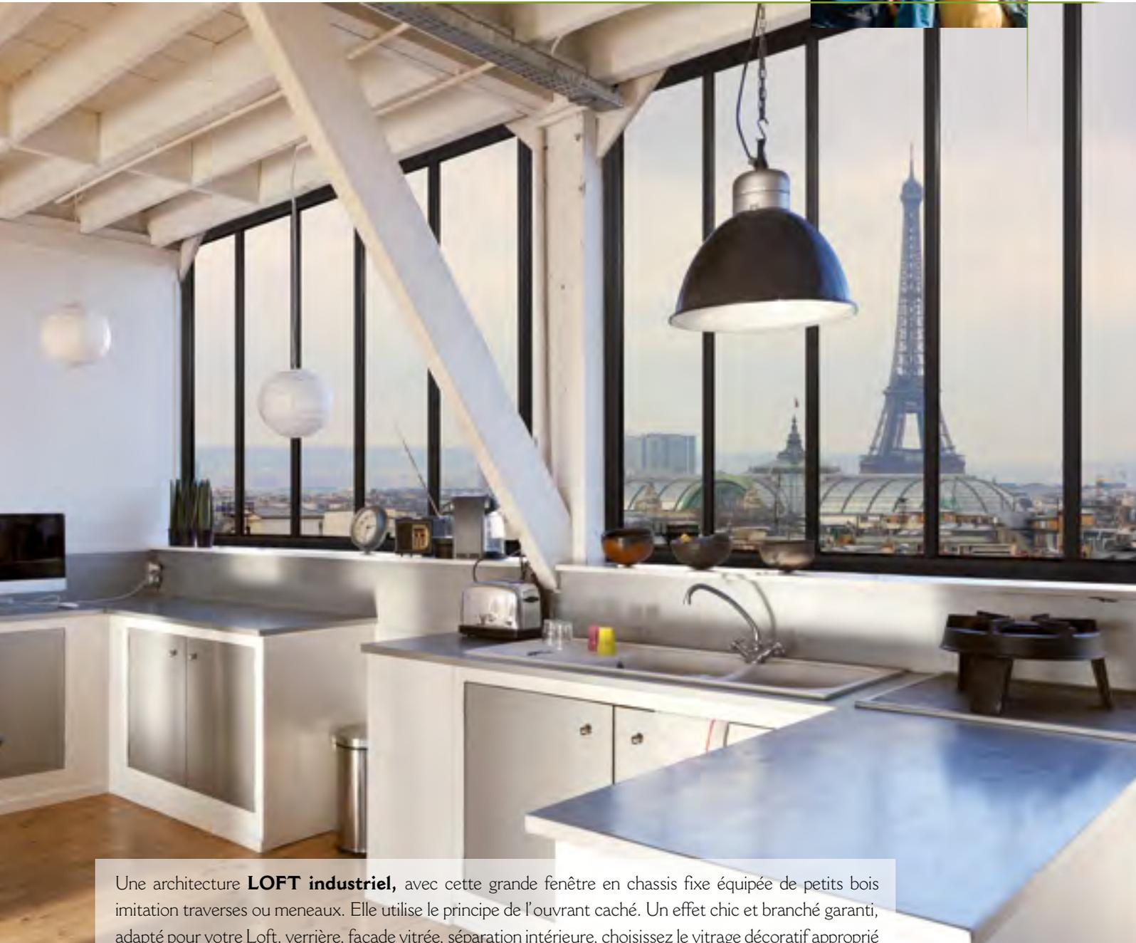
Une architecture **LOFT industriel**, avec cette grande fenêtre en chassis fixe équipée de petits bois imitation traverses ou meneaux. Elle utilise le principe de l'ouvrant caché. Un effet chic et branché garanti, adapté pour votre Loft, verrière, façade vitrée, séparation intérieure, choisissez le vitrage décoratif approprié (cf p 23). Ces petits Bois fictifs de 30 mm intégrés au vitrage, superposés par des plats de 40 mm sur les 2 faces imitent parfaitement les montants.
